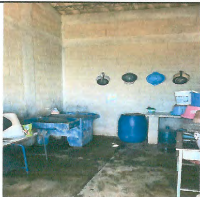
Foto 1: Reparación y Sustitución de Área de Cocina
